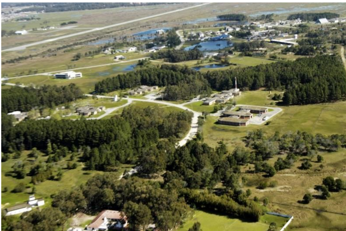
Figura 6: Vista aérea das instalações do Instituto de Oceanografia (Campus Carreiros) da Universidade Federal do Rio Grande (IO-FURG).
