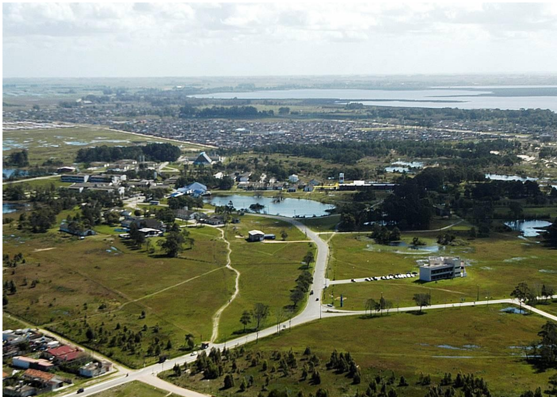
Figura 7: Vista aérea do Campus Carreiros da Universidade Federal do Rio Grande - FURG, local onde funciona o curso de Oceanologia.
