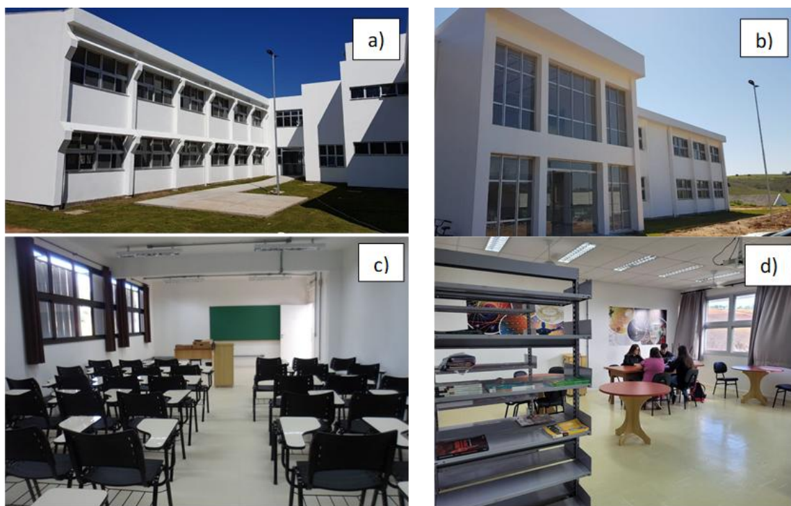
Figura 7. Pavilhão de salas de aula (a) e (b), sala de aula (c) e espaço colaborativo (d).
